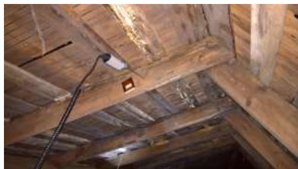
Kattotuolin anturointia. InviSensen anturi vielä peittämättä.
