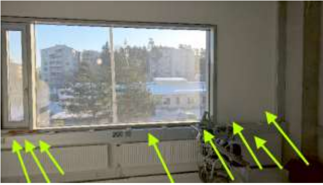
Seinärakenne valmiina maaliskuussa 2018
