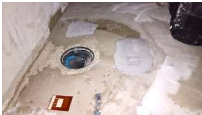
Anturien päälle vesieristettä
