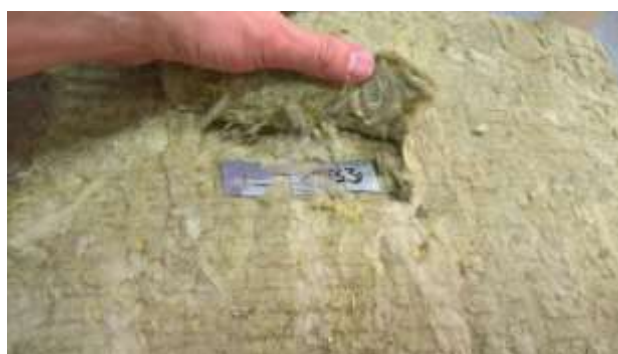
Smartrac asennetaan eristevillan sisään
