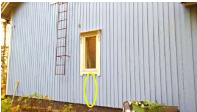
Anturien sijainti ulkoseinässä kylpyhuoneen ikkunan alapuolella
