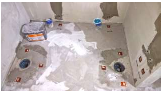
Anturien asennus tilaan C227
