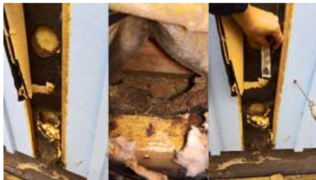
Anturien asentaminen ulkoseinärakenteeseen
