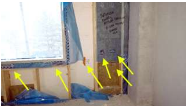
Anturien asentaminen huoneen C235 ulkoseinään
