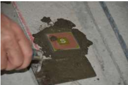
Vigilan anturin asentaminen sähkölämmitteiseen betonilattiaan
