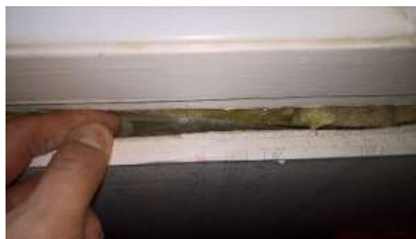
Anturi villan ja höyrynsulkumuovin väliin
