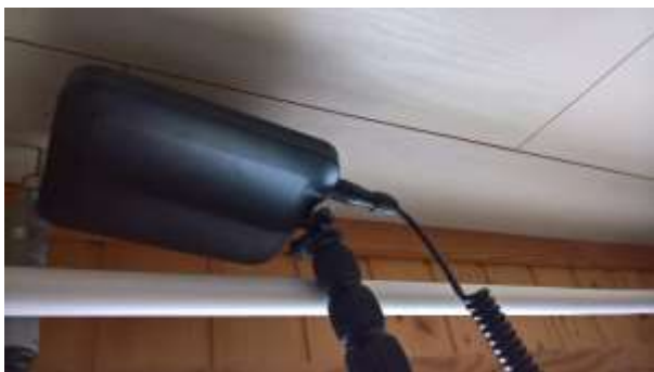
Yläpohjan anturien lukeminen huoneen katon läpi
