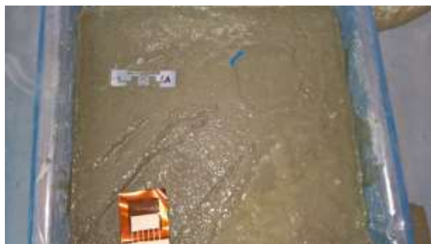
Anturit sijoitettuna neljännän laatan valuuun. Oikealla ylhäällä Vigilanin betonin kuivumisen seuranta-anturi. Muovinen kehikko varmistaa oikean asennussyvyyden.
