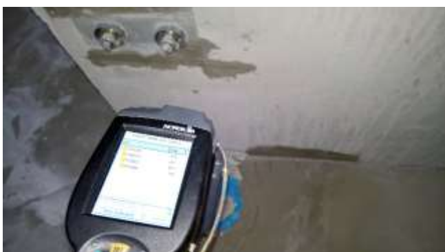
Anturien toimivuuden varmistaminen. Luku onnistuu seinän molemmilta puolilta samanaikaisesti
