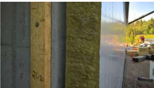
Metallipinnoitteisessa villaelementissä ei antureita voi käyttää
