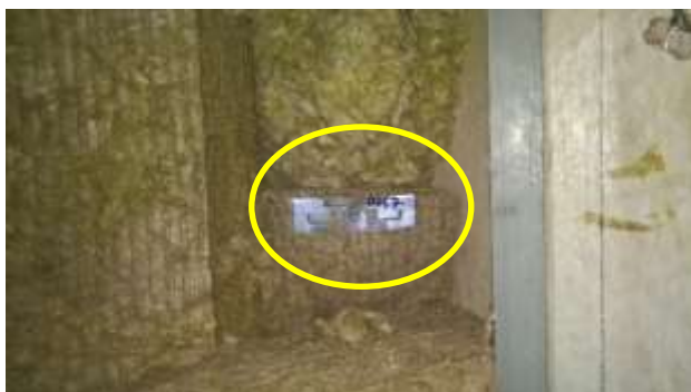
Smartrac anturi asennettuna eristevilloihin Metropolian Myyrmäen kampuksella
