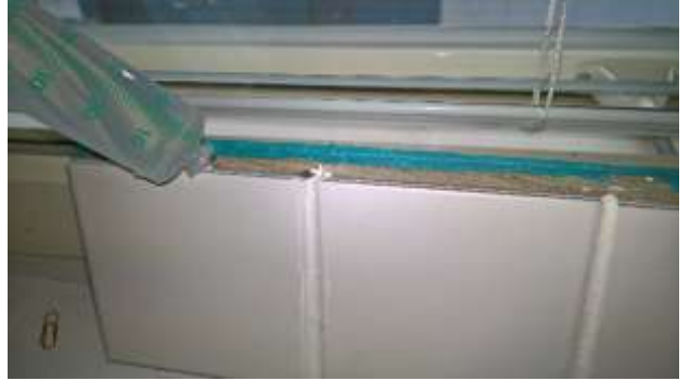
Laatoituslaastin kesteleminen - suihkussa käynnin simulointi
